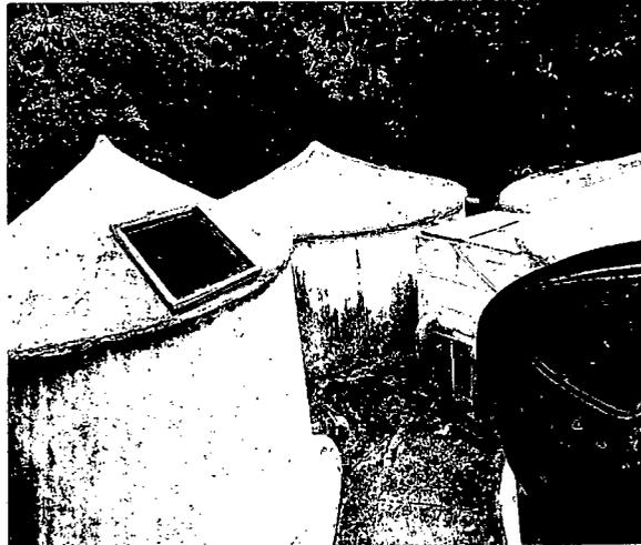
Foto 3. Tanques de ferrocemento
