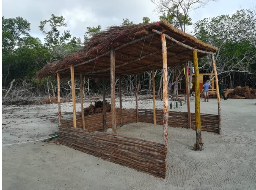
Foto 9. Enramada construida con varas de mangle, techo de palma. En coordenadas 75^{\circ}40'32.3''W 10^{\circ}08'21,9''N
