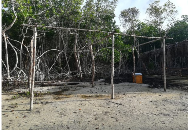
Foto 2. Varas en mangle, inicio de construcción de una nueva enramada en coordenadas 75°40'29.5"W 10°08'21.5"N
