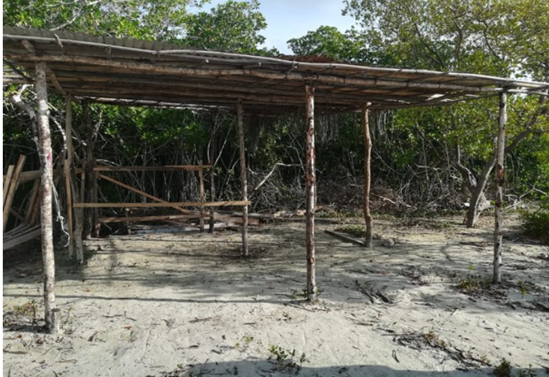
Foto 15. Enramada con varas de mangle y techo de zinc. Ubicada en coordenadas 75^{\circ}40'41,1''W 10^{\circ}08'23,1''N
