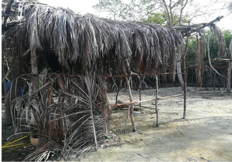
Foto 12. Enramada con varas de mangle y techos de palma. Ubicada en coordenadas 75^{\circ}40'37.8''W 10^{\circ}08'23.3''N
