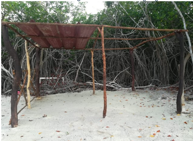
Foto 5. Enramada utilizando varas de mangle. Techo de zinc. Ubicada en coordenadas 75°40'30,7"W 10°08'21,8"N
