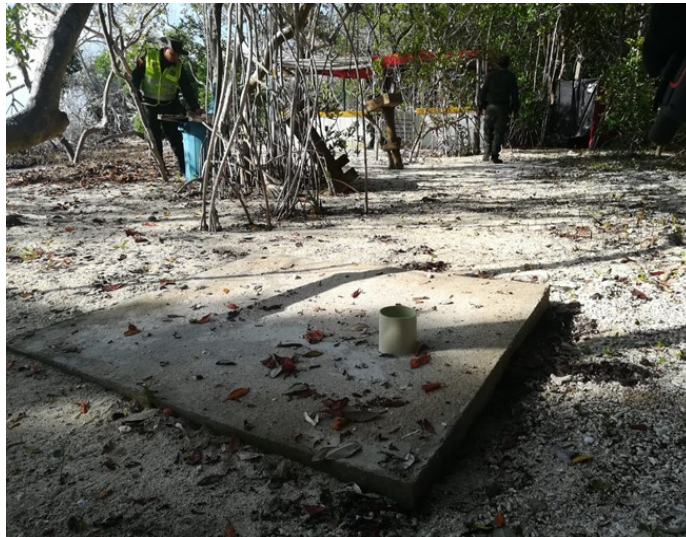
Foto 17. Placa en concreto con tubo de PVC de 6" en uno de los extremos. Posible baño. Ubicado en coordenadas 75^{\circ}40'51,3''W 10^{\circ}08'20,5''N
