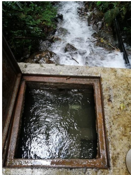
Foto 2. Estructura de captación y cámara de inspección
