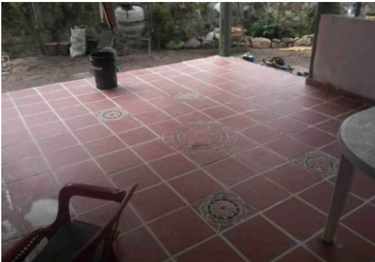
Ilustración 43 Baldosa común de cemento, tablón ladrillo (1)
