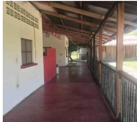
Ilustración 44 Baldosa común de cemento, tablón ladrillo (2)
