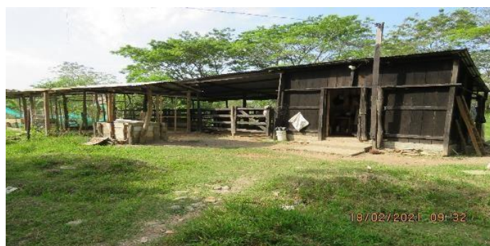
Figura 7. Parte de la zona de uso intensivo e infraestructura de la RNSC “AVE MARÍA”. Fuente visita técnica PNNC 17, y 18 febrero de 2021.
