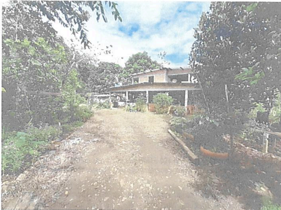
Figura 12. Zona de uso intensivo e infraestructura presente en la RNSC "LA ESPERANZA" Fuente: visita técnica PNNC 27 de julio de 2021.
