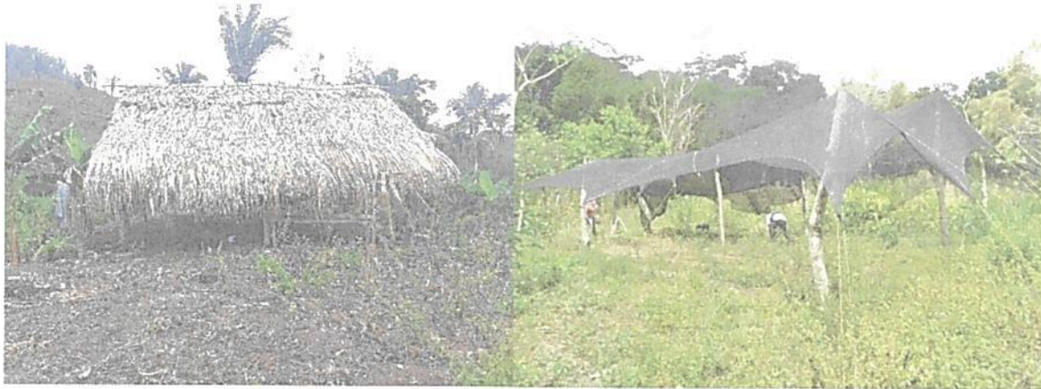
Figura 10. Zona de uso intensivo e infraestructura presente en la RNSC "EL CARACOLÍ" Fuente: visita técnica PNNC 18 de marzo de 2021.
